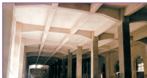
RIQUALIFICAZIONE COMPLETA DI CAPANNONI LASTRE CALCIOSILICATO R.E.I.
