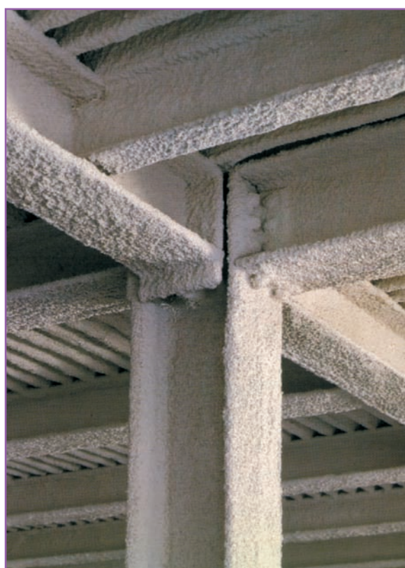
RIQUALIFICAZIONE STRUTTURA METALLICA INTONACO - R e R.E.I.
