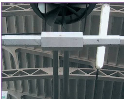
RIQUALIFICAZIONE TIRANTI IN METALLO COPPELLE - R e R.E.I.
